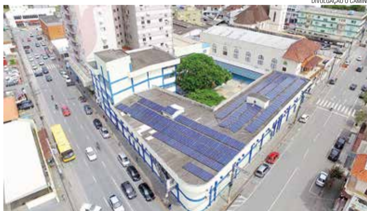
O telhado do prédio principal ficou todo coberto com as placas.
